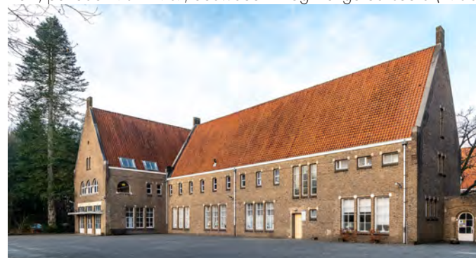
Gesloten bakstenen gevels
